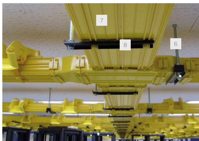
2. Instalace OptiWay na strop
